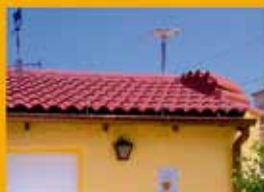
Dachbeschichtung & Dachrinnen Revestimiento de techos y canalones
