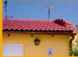
Dachbeschichtung & Dachrinnen Revestimiento de techos y canalones
